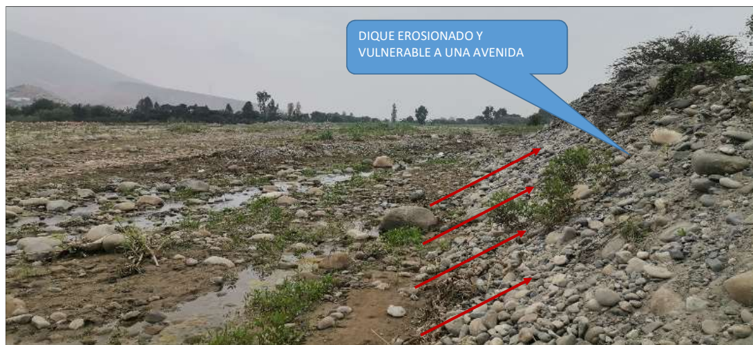
FIGURA N°03: TRAMOS EN EL MARGEN IZQUIERDO DEL RIO CHANCAY - HUARAL CON DIQUES DE PROTECCIÓN DETERIORADOS, ESTO PROVOCA QUE LAS INUNDACIONES SEAN MAS INMINENTES EN EPOCAS DE AVENIDAS.
