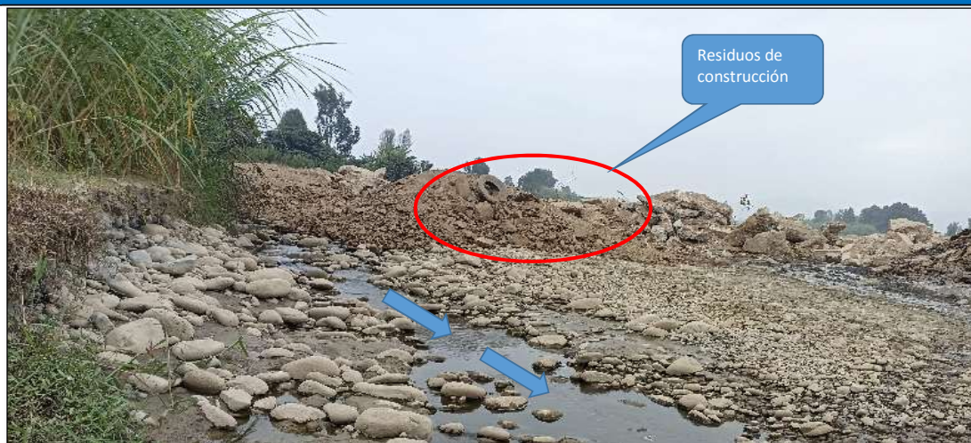
FIGURA N°01: RIO CHANCAY - HUARAL COLMATADO CON LA PRESENCIA DE RESIDUOS DE CONSTRUCCIÓN Y OTROS, TANTO PARA AMBAS MARGENES COMO EN EL EJE DEL RIO, OCASIONANDO LA REDUCCIÓN DEL ÁREA HIDRÁULICA SUSTANCIALMENTE, LA CUAL PRODUCE EL DESBORDE DEL RÍO HACIA AMBOS MARGENES.
